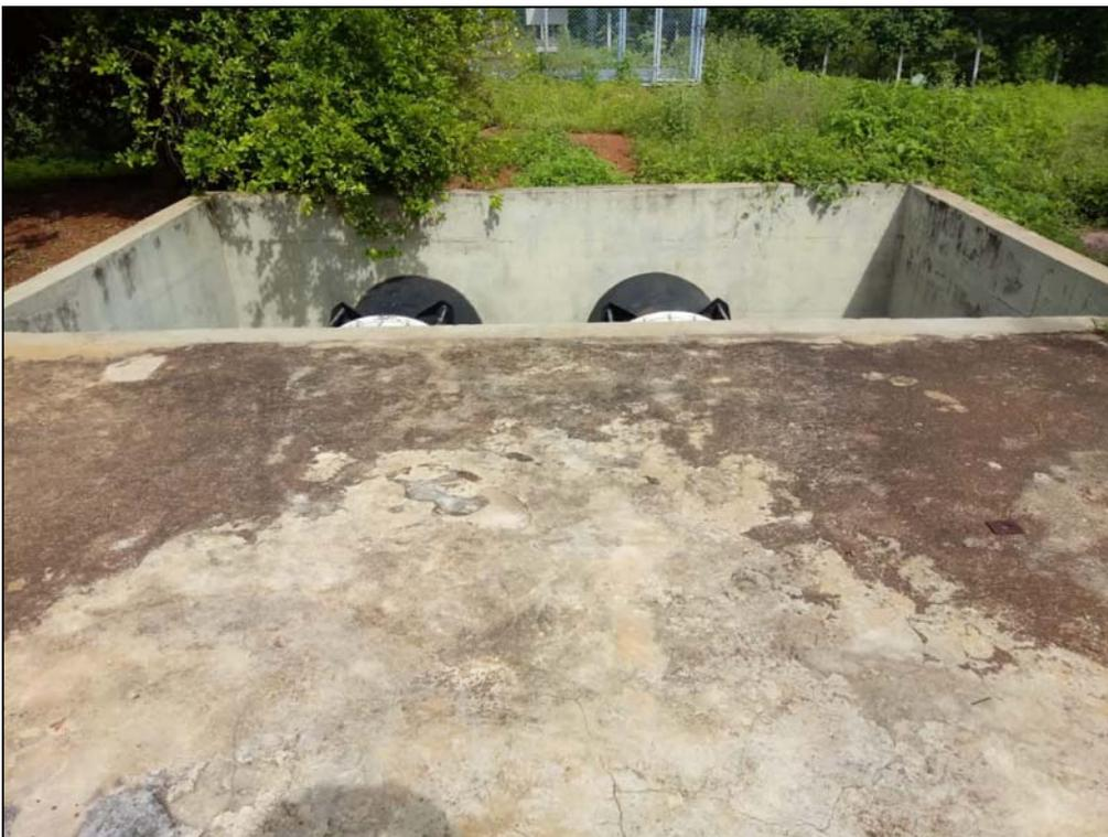
**Caixa de Válvulas das Adutoras de Recalque de 1.200mm**
